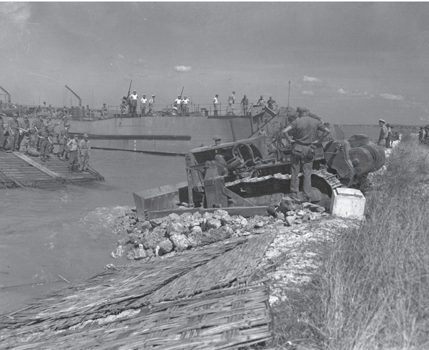
Debarkatie op Madoera, 1947: genisten bouwden in Nederlands-Indië nieuwe verbindingen en herstelden door Indonesische guerrillastrijders vernielde bruggen en wegen
