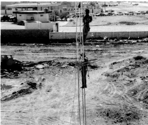
Werken aan het communicatienetwerk in An Nasiryah (Foto: auteur)
