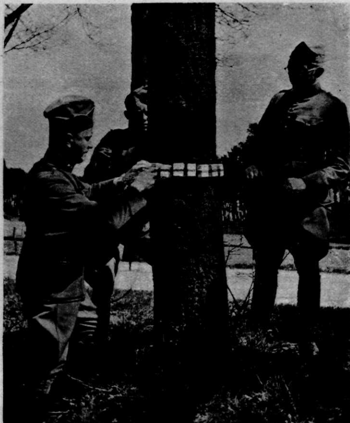
Een leeren bandje met trotyl-blokjes wordt om een boom aangebracht. Als de lont ontstoken wordt valt de boom binnen eenige seconden schuin over den weg.
