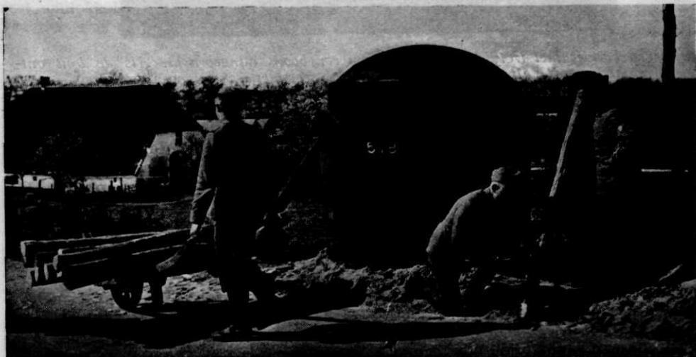
Gegoten stalen koepel van 10 cm dikte gedeeltelijk ingegraven, welke den mitrailleurschutter beschermt tegen kogels en scherven.
