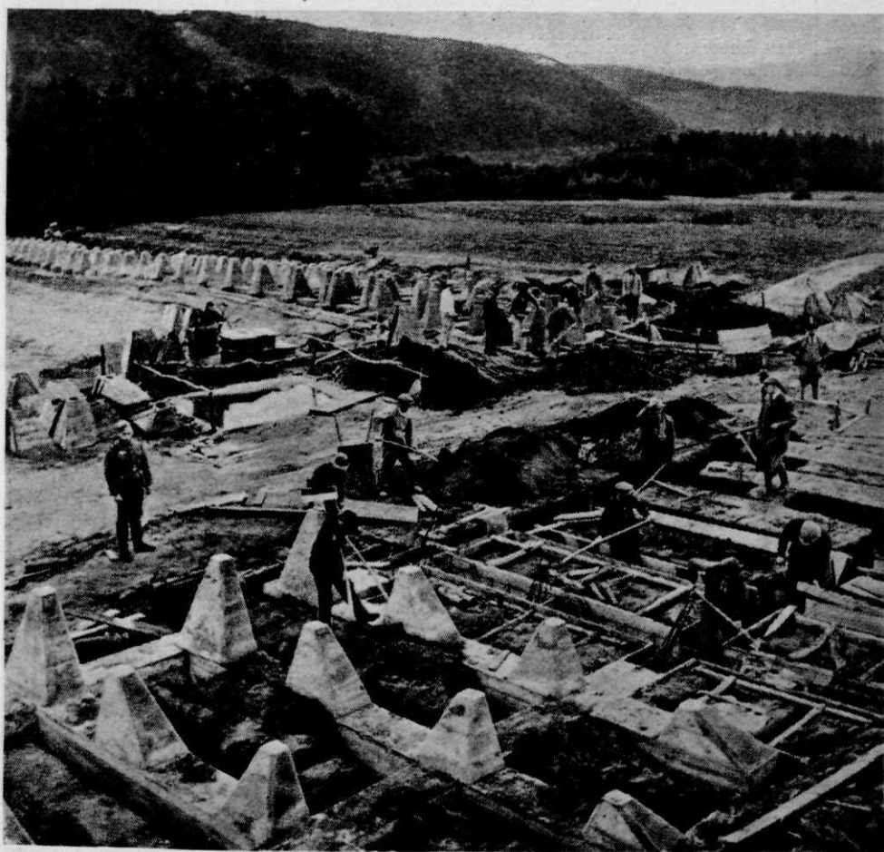
Afb. 3. Hindernissen uit beton tegen pantserwagens, ondergronds door zware betonbalken verbonden.
