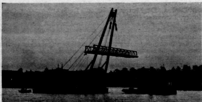
Afb. 1. Het vervoer van een vakwerkspanning met behulp van een bok op de Oude Maas voor Dordrecht. Deze vakwerkspanningen dienen als aanleghoofden voor de vloten van den „Veerdienst”, waarvan fig. 2 een afbeelding geeft.
