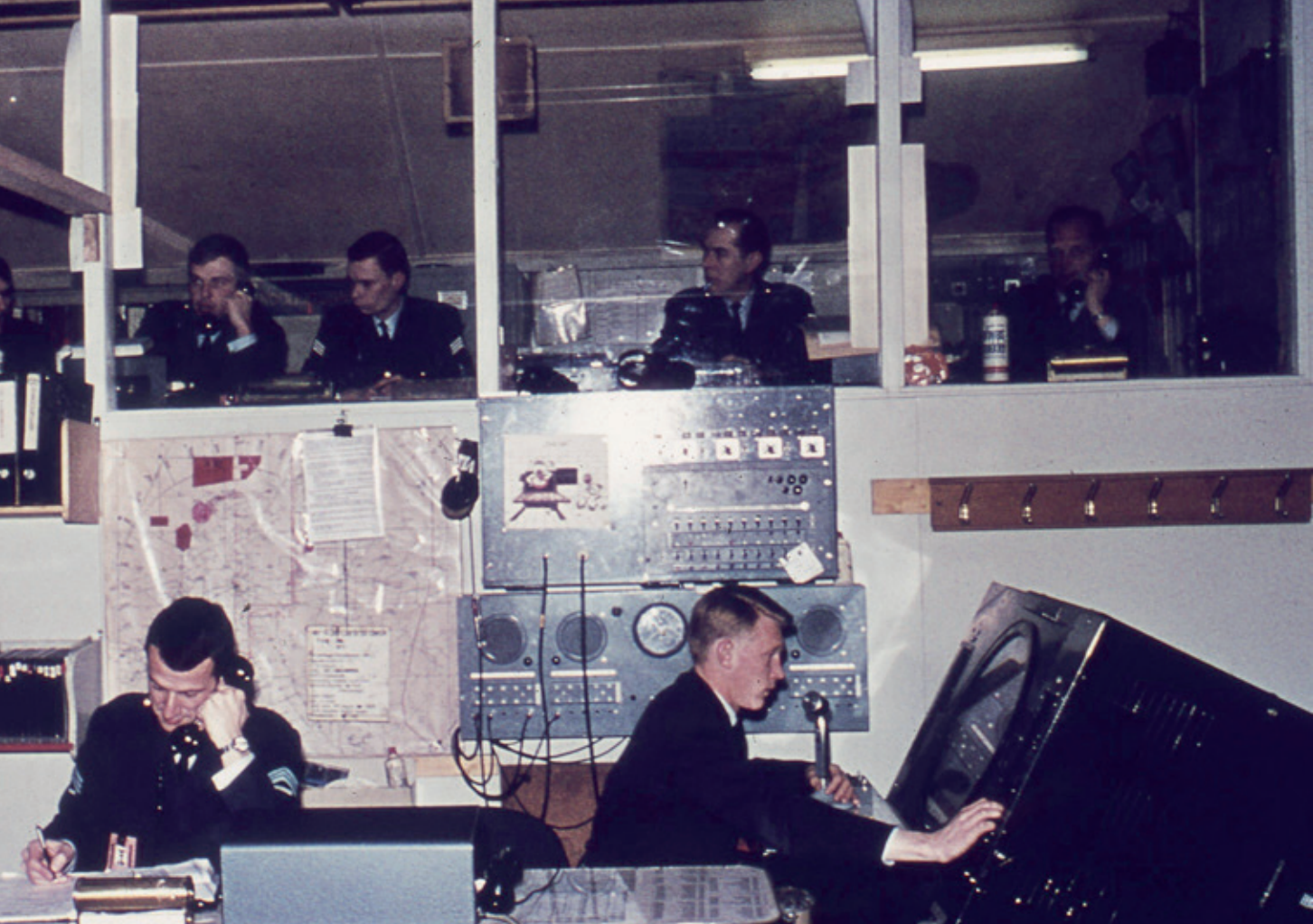
Het luchtverdedigingsoperatiecentrum in Driebergen stond op de lijst van potentiële kernwapendoelen
