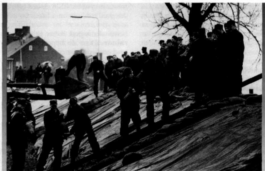
Aanleggen van een nooddijk bij Kampen (1996)
