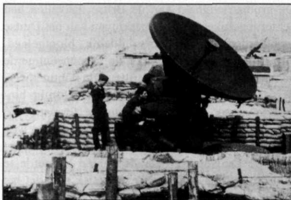
Afb. 3 Een operationele Würzburg-radar in de duinen. Deze door Telefunken geproduceerde grondradar was een onmisbare schakel in het Himmelbett-systeem.
