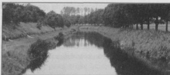
Afb. 5a Foto van het Valleikanaal in noordwestelijke richting, coördinaat FT 684732
