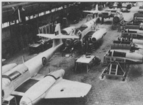
Afb. 1 Belgische en Nederlandse Meteors Mk.8 in aanbouw in de Fokkerfabriek te Amsterdam-Noord; de in 1949 op gang gekomen serieproductie van moderne gevechtsvliegtuigen heeft het naoorlogse herstel van de vliegtuigindustrie in Nederland sterk bevorderd
