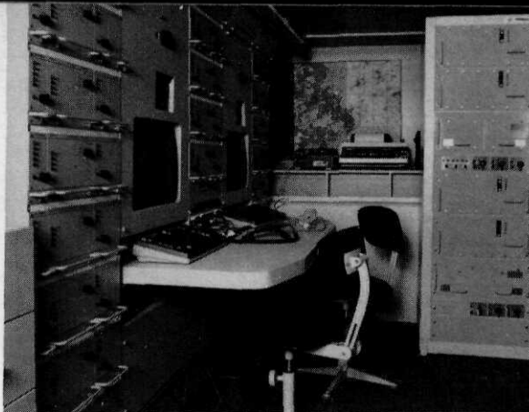
Afb. 4 Met processors gestuurde schakelautomaatinstallatie
