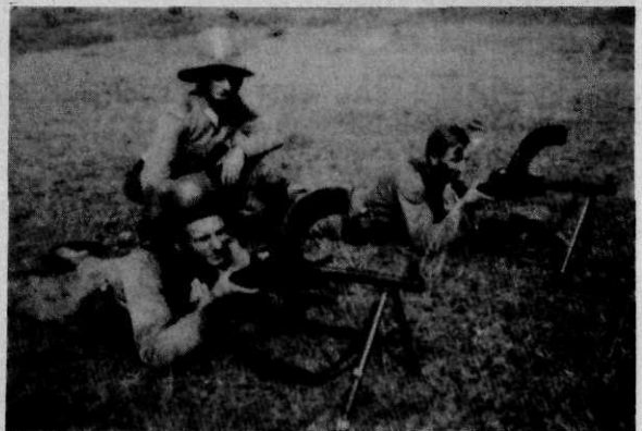
Afb. 3 Karabijnmitrailleurs tijdens schietoefeningen. Het wapen was oorspronkelijk een geweermitrailleur; de loop werd ingekort ter aanpassing aan de lichaamslengte van de inheemse militairen (foto Stabelan)
