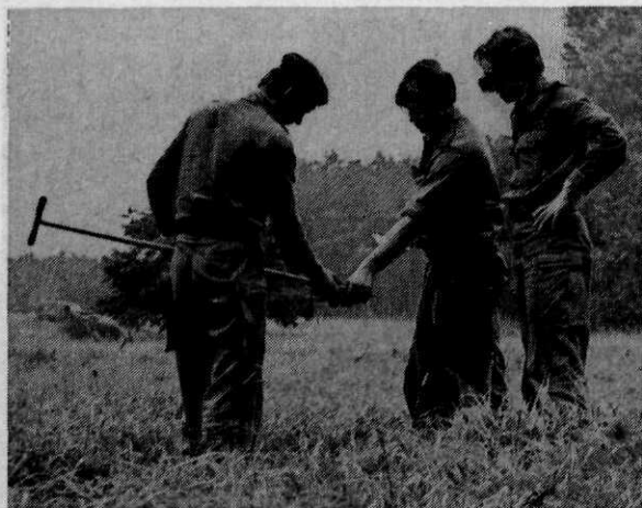
Afb. 7 De boor, onmisbaar instrument bij grondonderzoek
