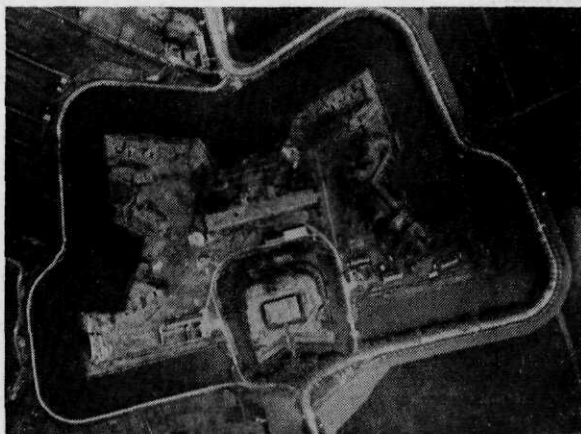
Afb. 11 Fort de Bilt, aangelegd van 1816 tot 1819 als gebastioneerd aardwerk met aarden reduit
