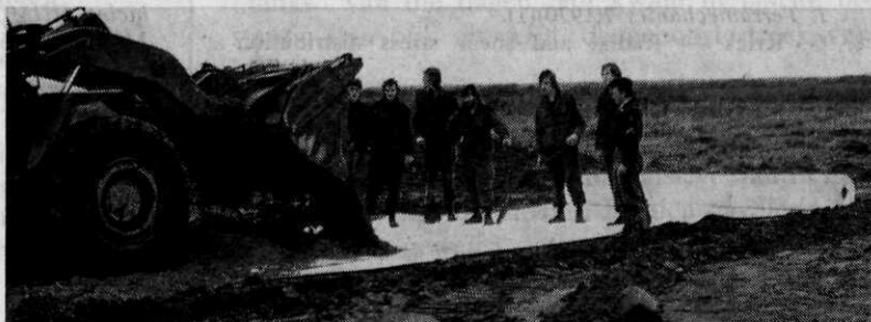
Afb. 33 Het aanbrengen van een kunststofvezelvlies op een proeftraject
