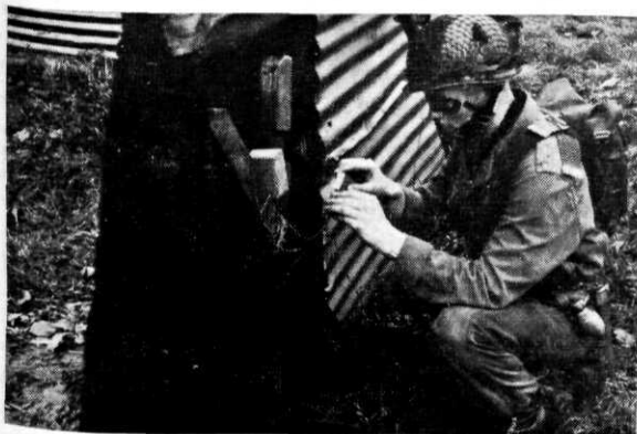
Het plaatsen van een ramlading (vuurkoord met slagpijpje)
