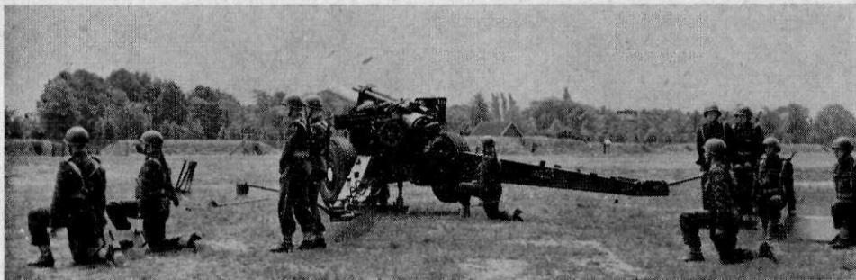
Afb. 2 Het omzetten van een grote hoek met behulp van de vijzel
