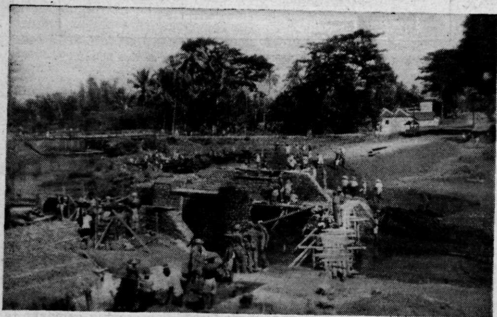
Afb. 3 Afdamming is verwijderd. Pijler gereed. Noordelijk landhoofd wordt gevoegd. Links het oude weggedeelte met de Bailey-brug. Rechts de aarden baan van de nieuwe weg
