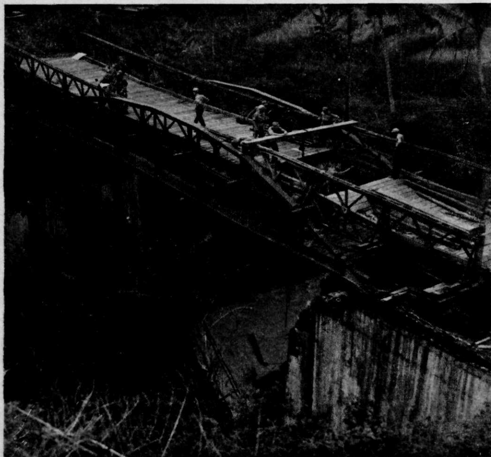
Afb. 5. Als afb. 4, maar genomen van bovenstroomse zijde. (Poerwakarta-oever.) Men kan de vernielde oude brug tegen het landhoofd zien liggen.
