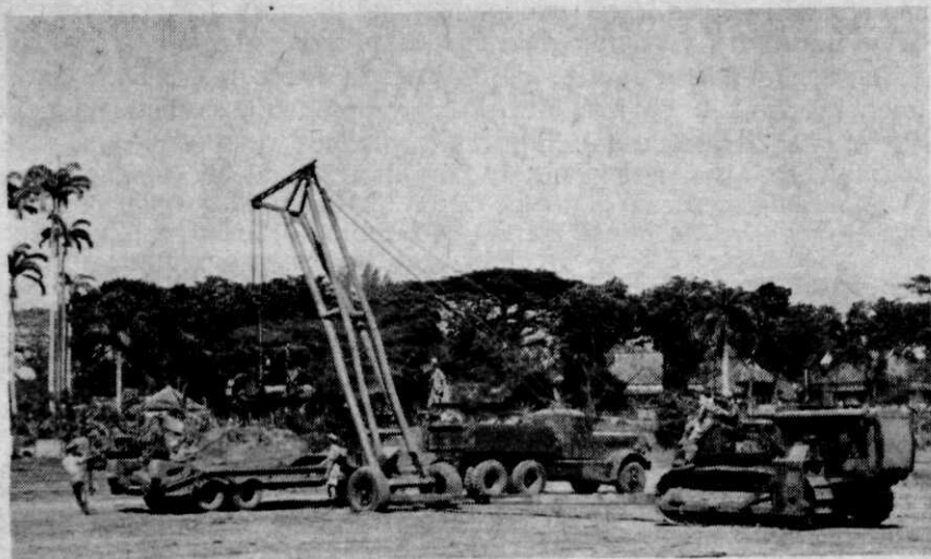
Afb. 1. Een 5-tons „Le Tourneau” kraan in gebruik bij het laden van een tractor (D 4) op een 40-tons trailer. De kraan wordt bediend met de lier van de tractor op de voorgrond.
