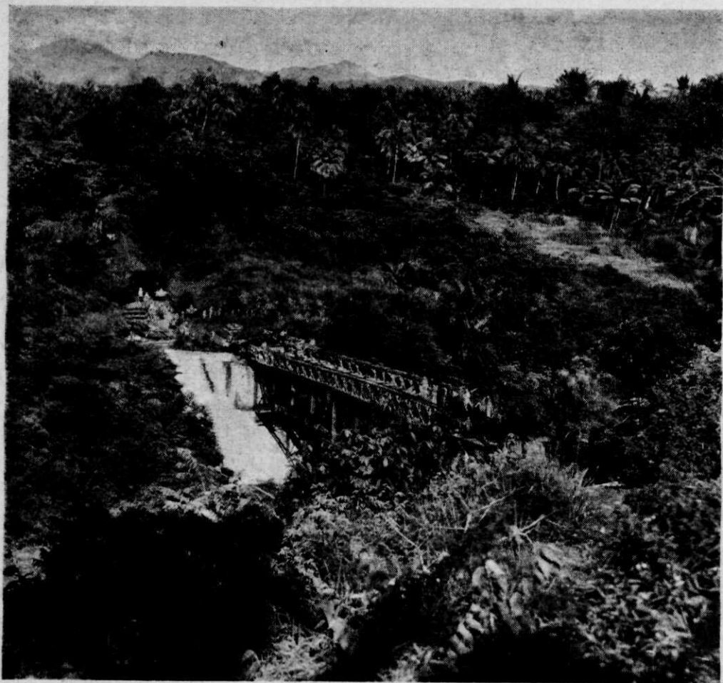
Afb. 8. Overzicht van de demontage van de reeds tot 3—1 gereduceerde 3—2 Bailey te Tjirandjang. Men ziet de versterkte vakwerkbrug onder de Bailey liggen. Een „break-down” auto en een als kraan werkende dragline helpen op beide oevers met het tillen van de zware lasten. Foto genomen van bovenstroomse zijde, Tjirandjang-oever.
