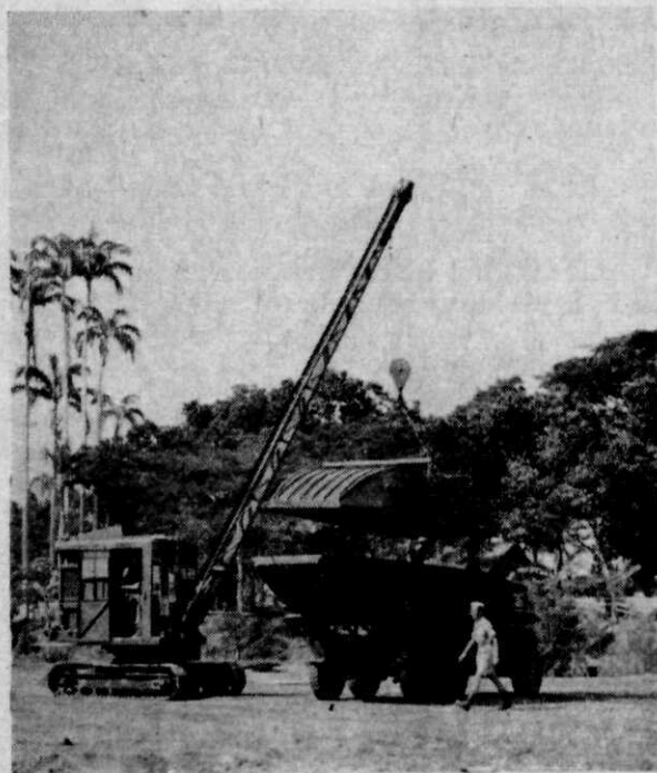
Afb. 2. Excavateur, ingericht als kraan, in gebruik bij het laden van Bailey-pontons.
