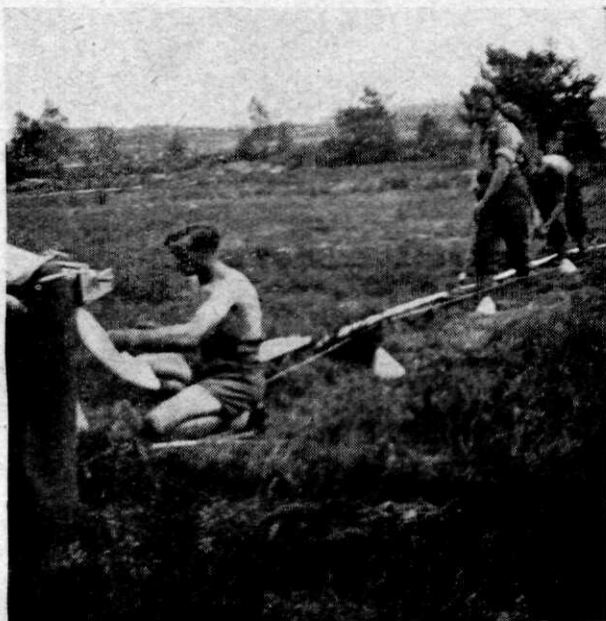
Afb. 4. Een pad van 30 cm breed wordt in een mijneveld gemaakt.
