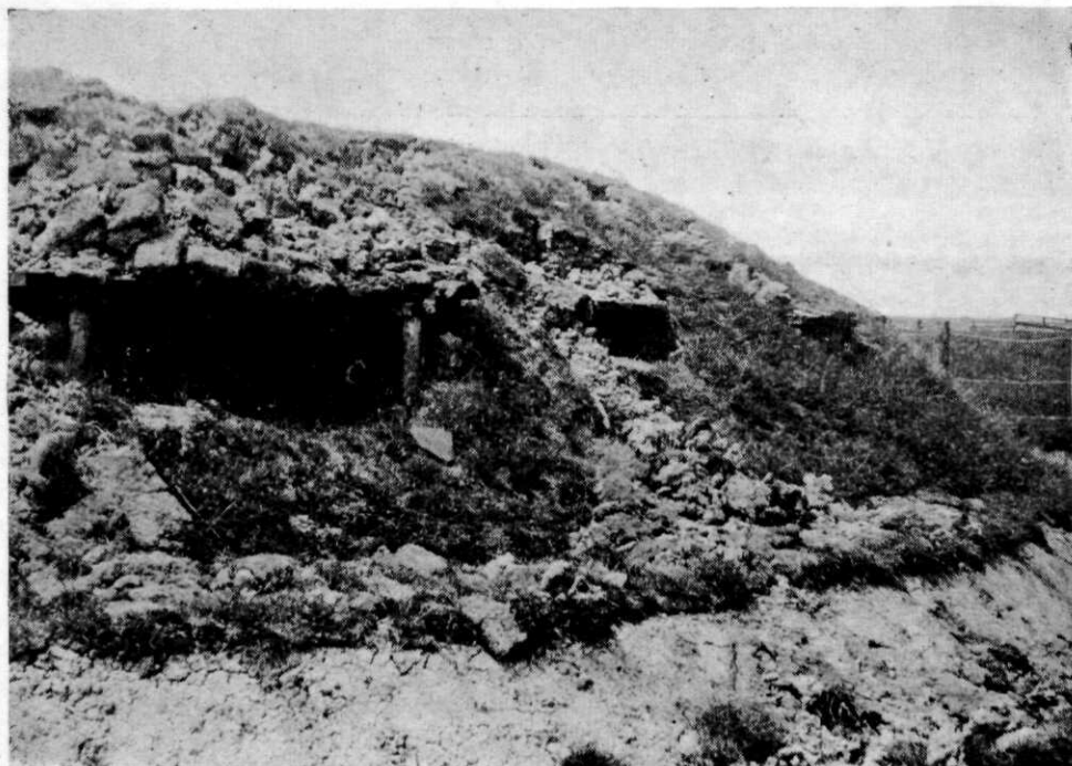
Kazemat na afloop van den strijd. (Foto Hoofdregelingsbureau)
