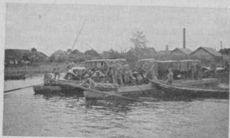
Afb. 3 en 4. De vervaardigde vlotten, met de auto's en voertuigen geladen, die met de sleeptouwen worden getrokken.
