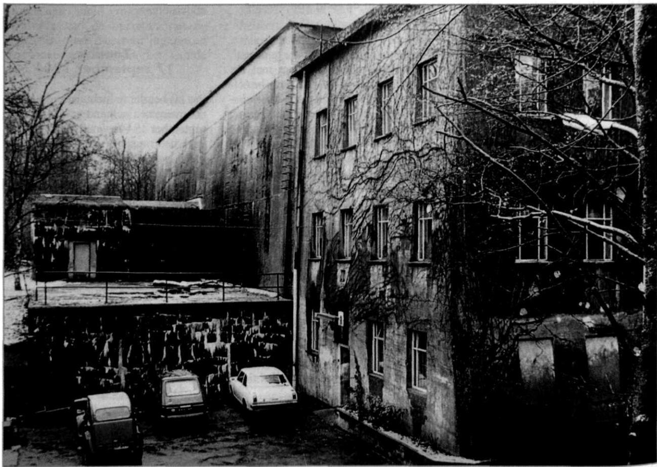
Afb. 2 Het bunkercomplex Diogenes in Schaarsbergen. Rechts het administratiegebouw, dat tegen de oostgevel van de eigenlijke bunker staat (Foto: archief auteur)
