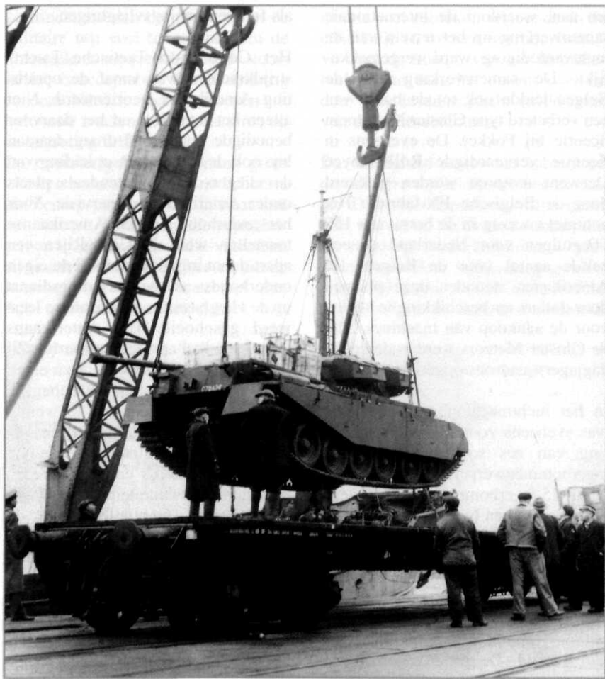
Afb. 2 De eerste van drie Centurion-tanks worden per stoomboot verscheept van Engeland naar Nederland (Bron: Enclosures to despatch The Hague 1226)
