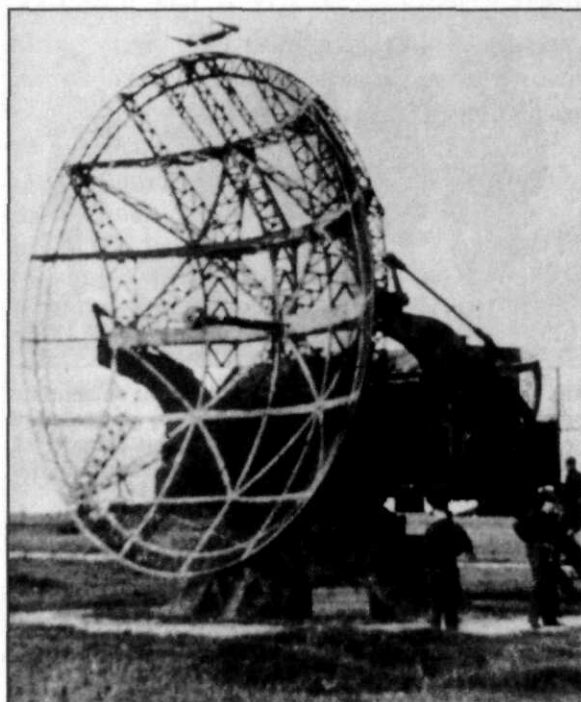
Afb. 5 De imposante Würzburg-Riese grondradar bleef tot het einde van de oorlog van betekenis voor de Duitse luchtverdediging.
