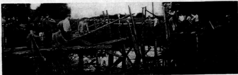
Afb. 2. Het opzetten van de schragen.
