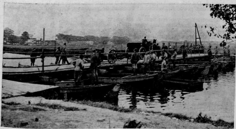
Afb. 2. 1 R.V.A. uit Utrecht trekt over de brug.
