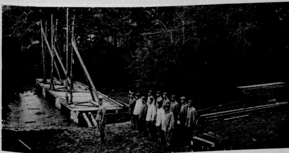
Afb. 4. De werkbrug en de heistellingen gereed.
