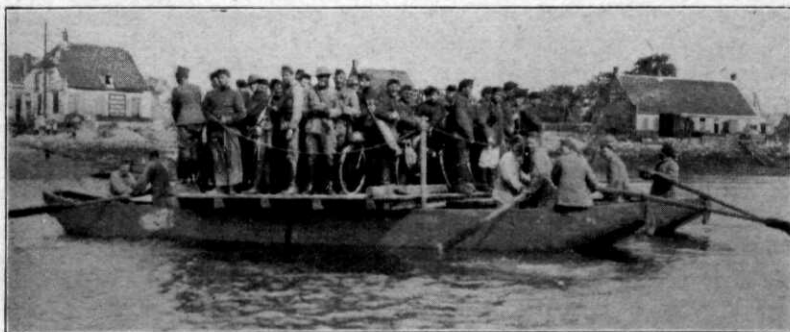
Vlot van 2 pontons No. 4, met 50 volledig uitgeruste manschappen, 10 pontonniers, 1 vlotcommandant (pontonnier).
