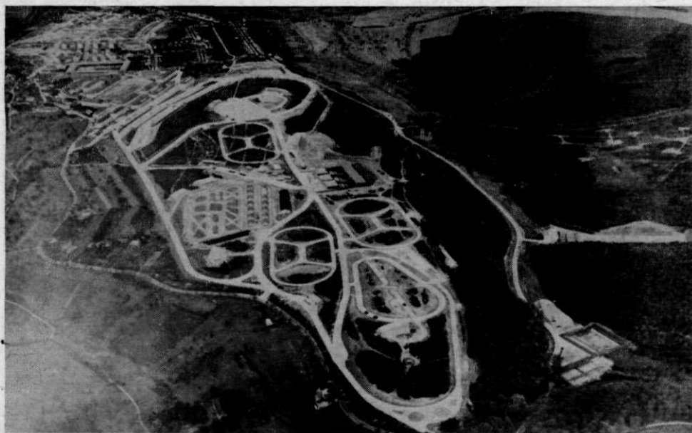
Tankrijbanenproject te Trier
