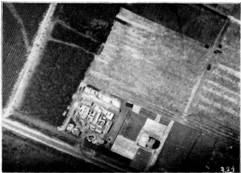
Huis in aanbouw nabij Soesterberg, hoogte 450 M. Bij deze opname was de as der camera loodrecht omlaag gericht.
