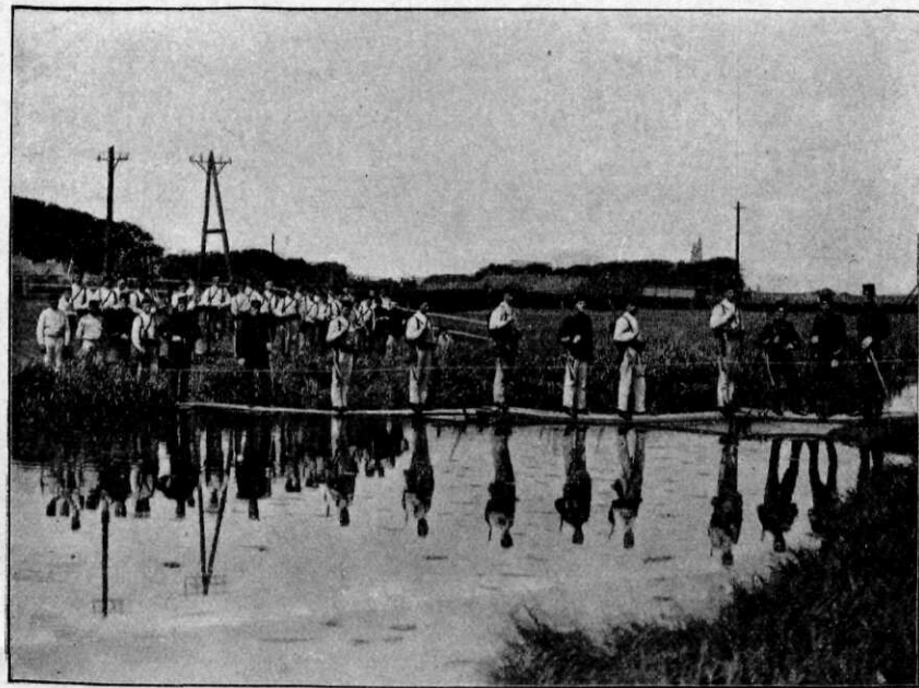
Brug met leuning; brugdek van ladders plm. 6 M. lang, waarop planken. Deze brug werd door den troep, met den looppas en zoo dicht mogelijk opgesloten, overgetrokken.
