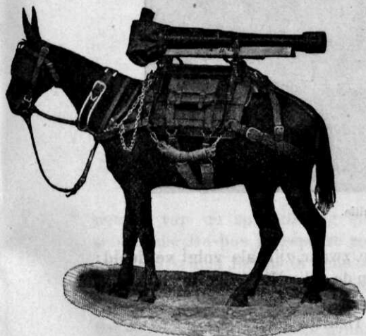
FIG. 8. Vuurmond met sluitstuk en pantser voor de bovenaffuit.
